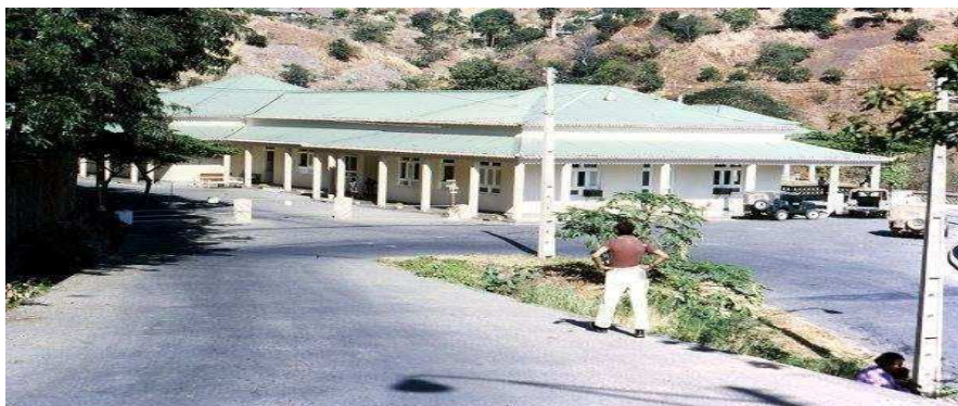
Figura 2 - Edifício principal onde funcionava a cirurgia geral e a maternidade
