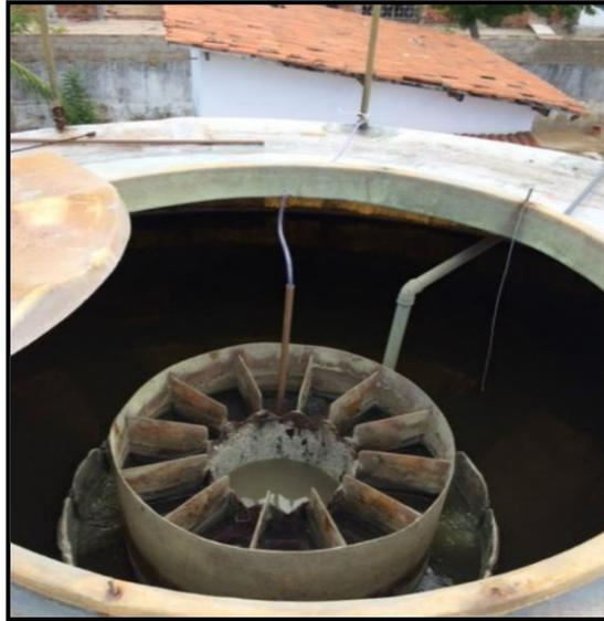
**Figura 5:** Microaeração instalada no *headspace* do reator.
