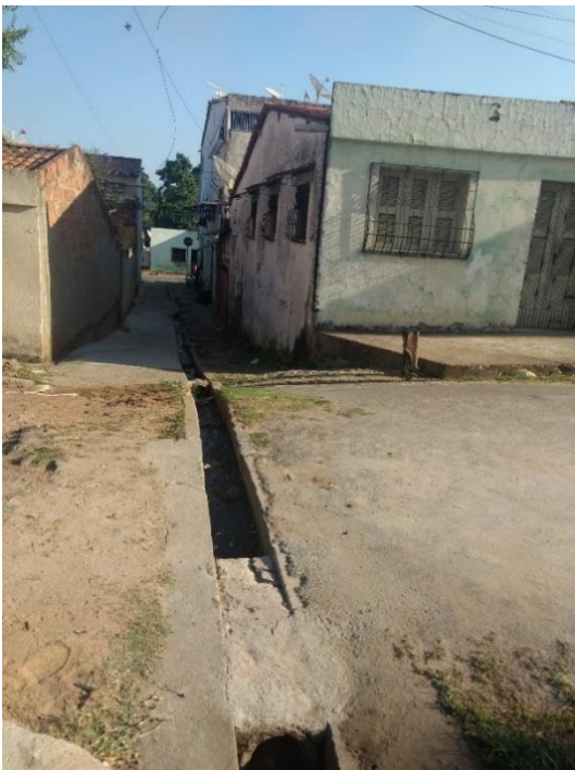
Figura 6: Foto de via pública com esgoto a céu aberto na Rua Santa Rita.
