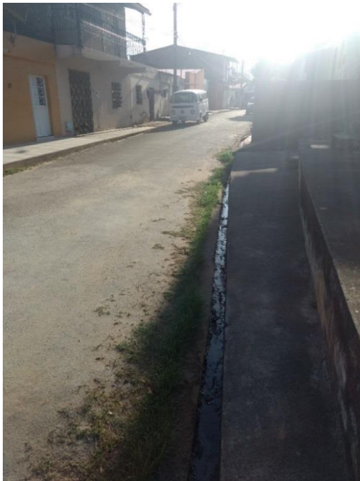
Figura 6: Foto de via pública com casas geminadas e esgoto a céu aberto na Rua Santa Rita
