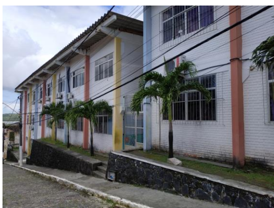
Foto 4 - Escola Frei Eliseu Eismann - Rua do Espírito Santo – Centro, São Francisco do Conde
