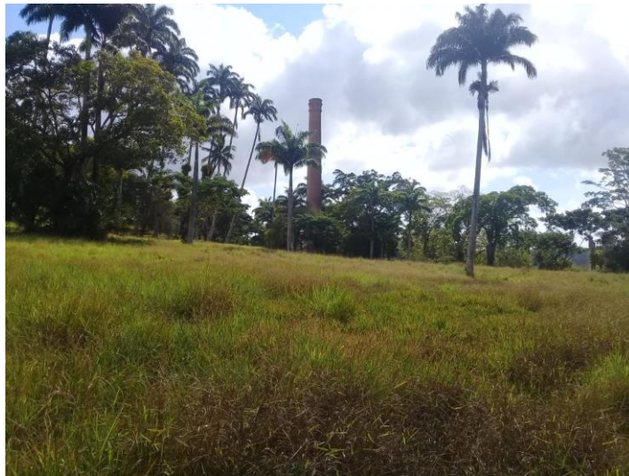
Figura 1 - As Ruínas do Bueiro da Usina em Dom João
