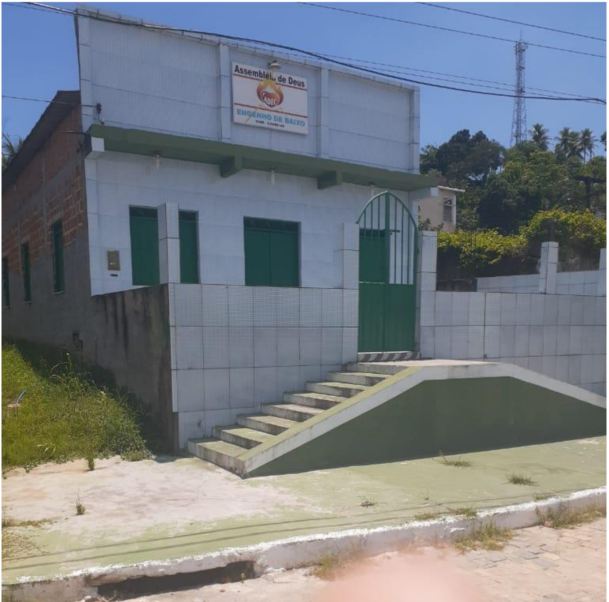
Figura 14 - Igreja Assembleia de Deus no Engenho de Baixo
