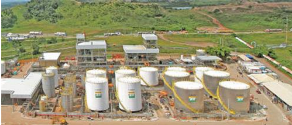
Figura 3 - Usina de biodiesel da PETROBRAS em Candeias/BA
