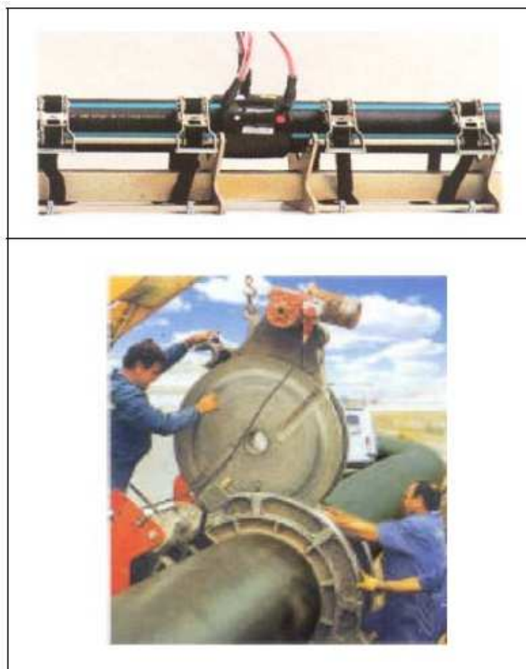
Figura 7- Solda de uma tubulação de Polietileno.
