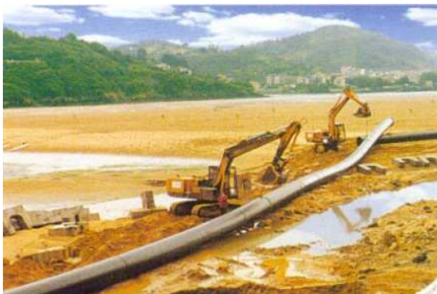
Figura 3 - Instalação de uma tubulação de PEAD.
