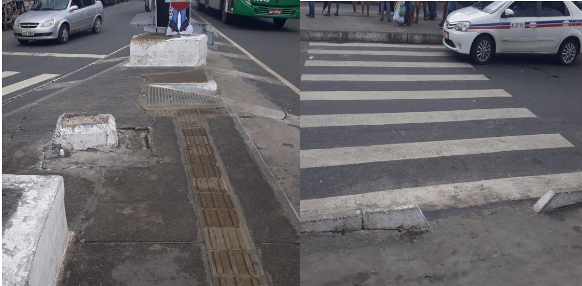
Figura 5 - Pavimento irregular com obstáculo na calçada Rampa de acesso em apenas um dos lados da travessia
