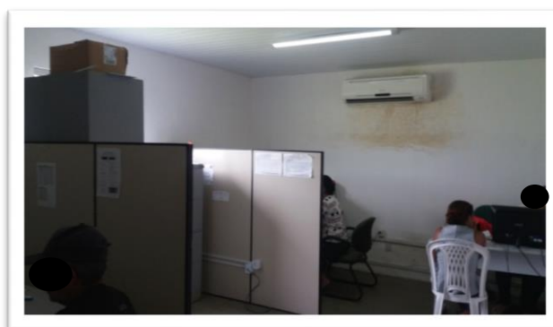
Figura 26 – Sala de atendimento de nível médio do CRAS Jereissati, Maracanaú-CE, 2018
