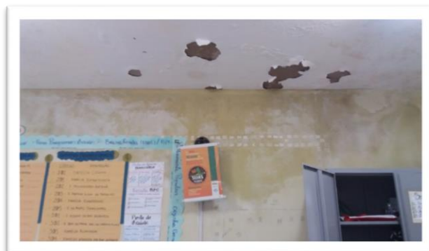
Figura 45 – Parte interna da sala de atendimento de nível médio CRAS Timbó, Maracanaú-CE, 2018
