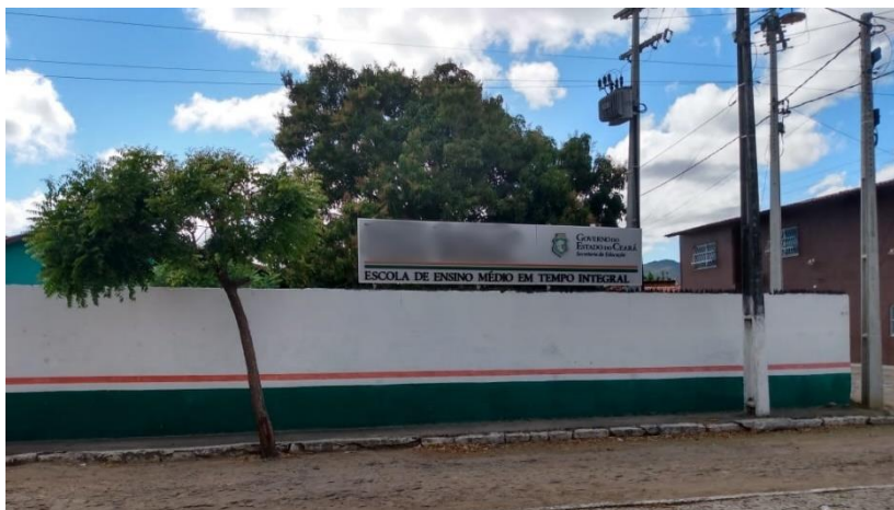
Figura 3 – Fachada da EEMTI estudada
