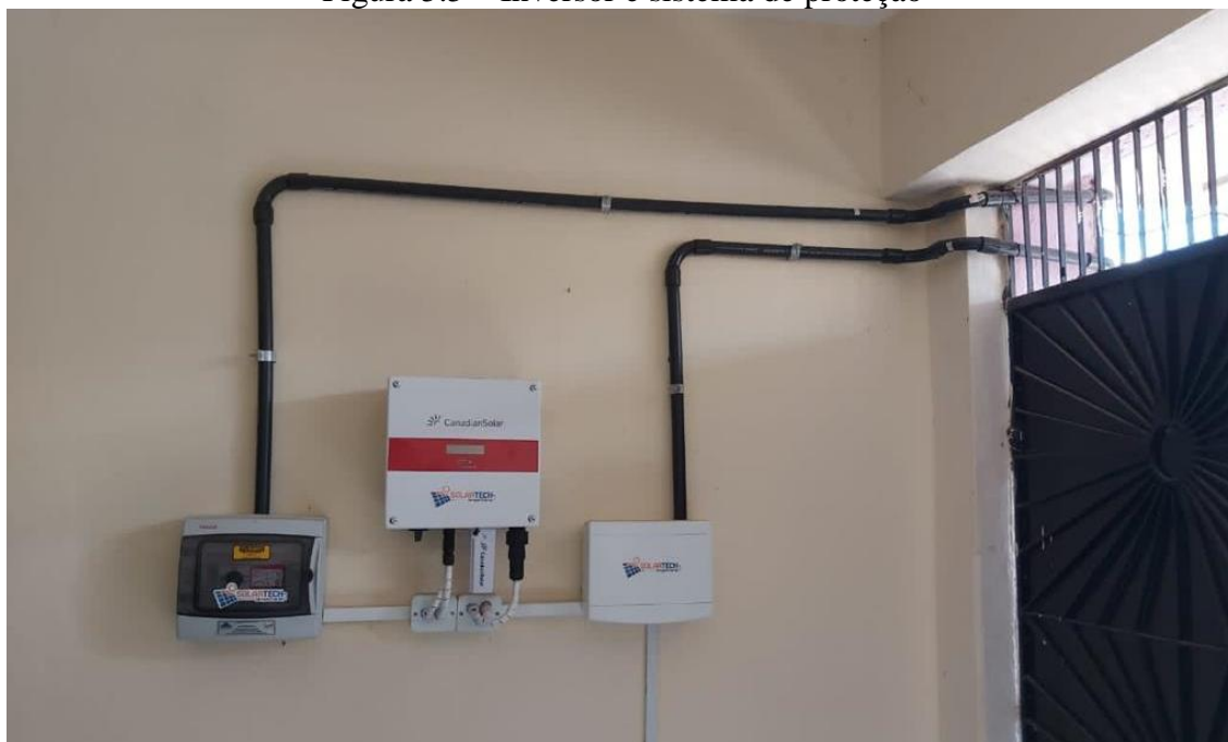
Figura 5.5 – Inversor e sistema de proteção
