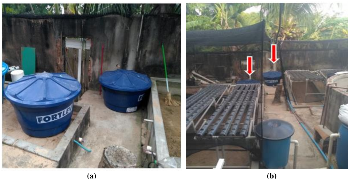
Figura 4.7 –Caixas de 250L utilizadas como sump (a) e sistema de aquaponia (b)
