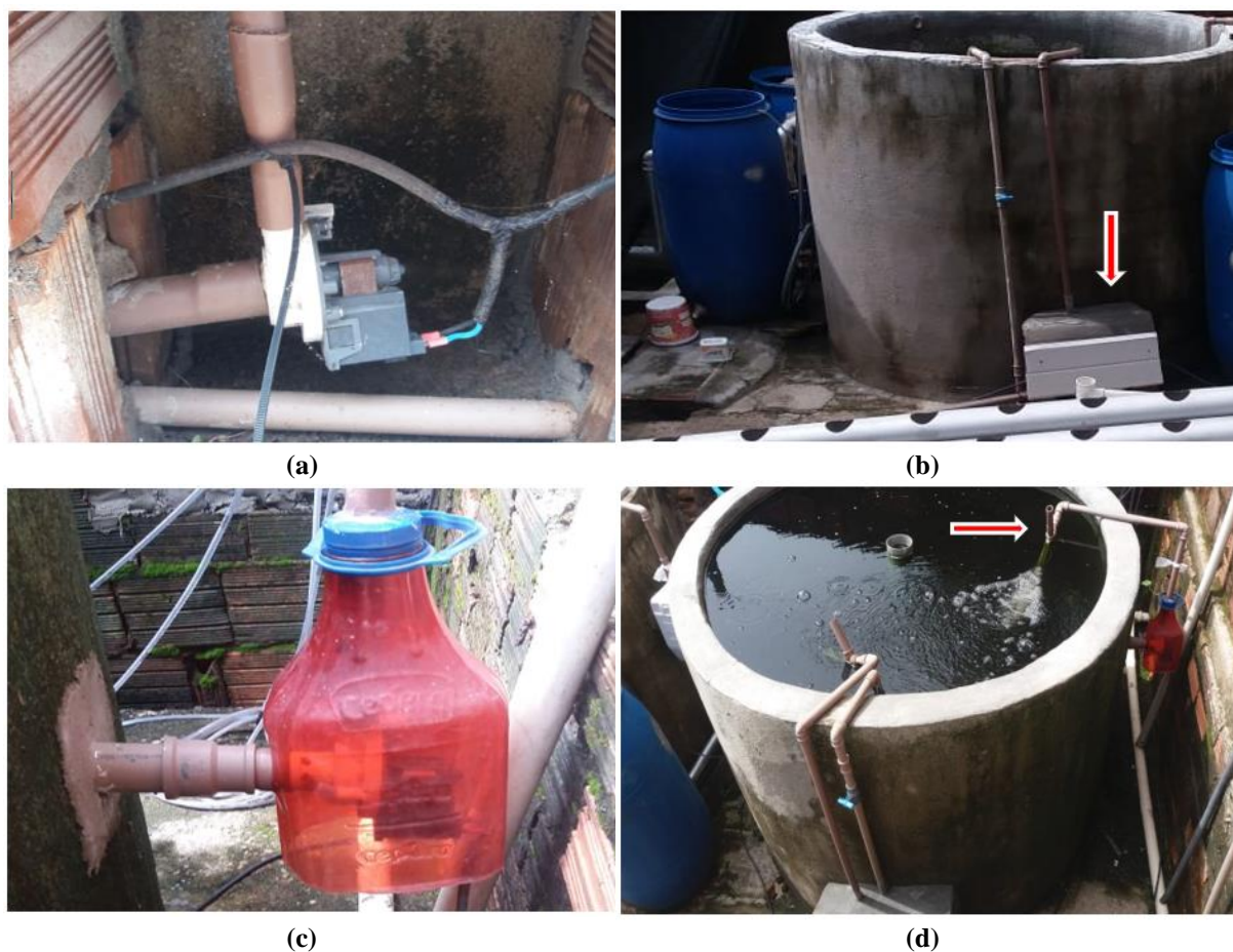
Figura 4.8 – Sistema de bombeamento e aeração por eletrobombas alternativas
