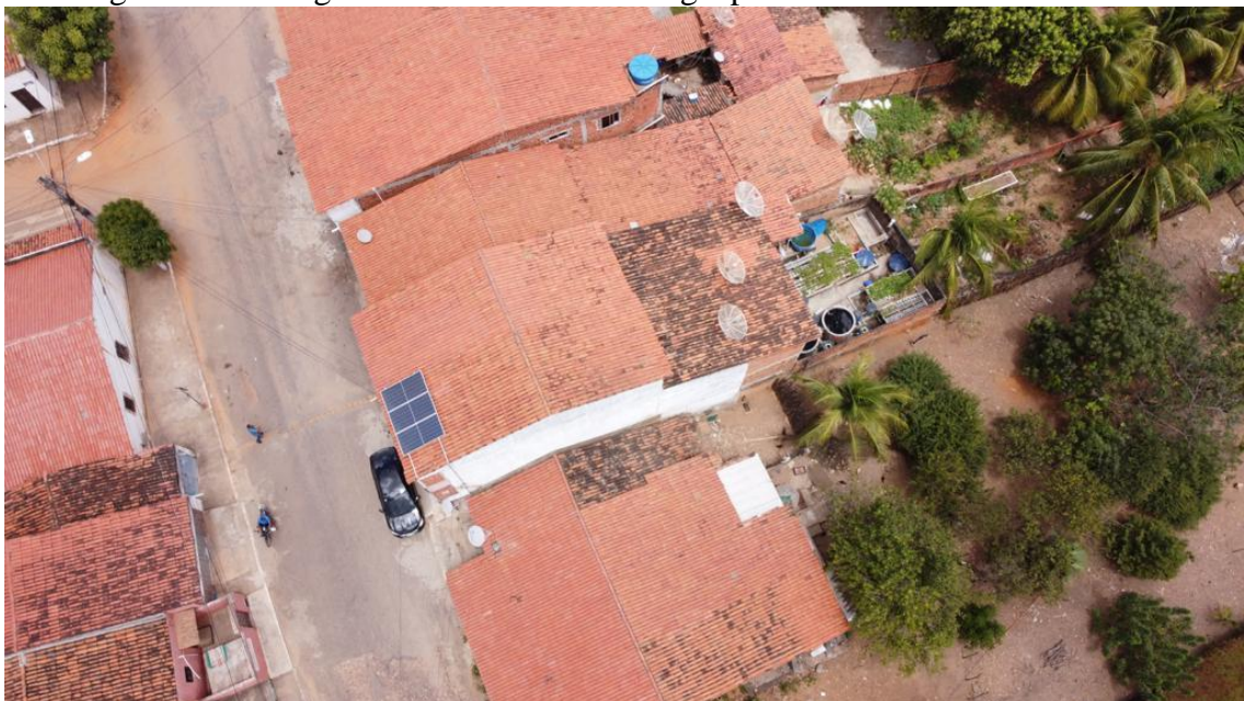
Figura 5.4 – Imagem aérea do sistema de aquaponia e do sistema fotovoltaico
