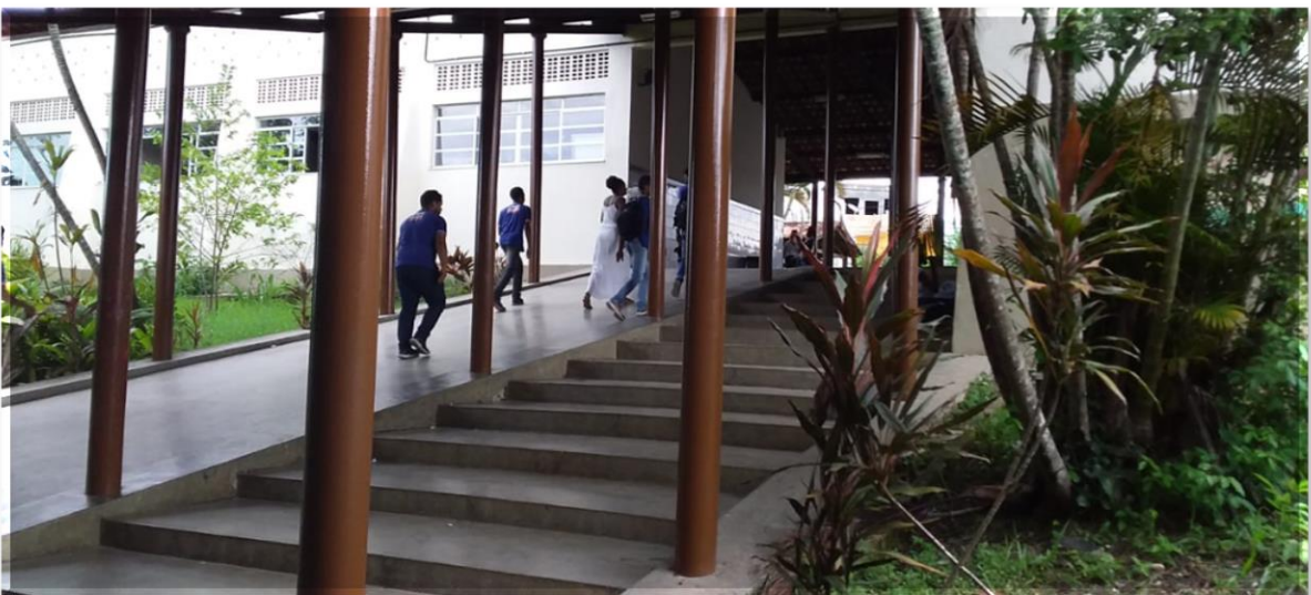
Imagem interna do pátio central e acesso exclusivo ao 1º pavilhão do Centro Educacional Teodoro Sampaio (CETS).
