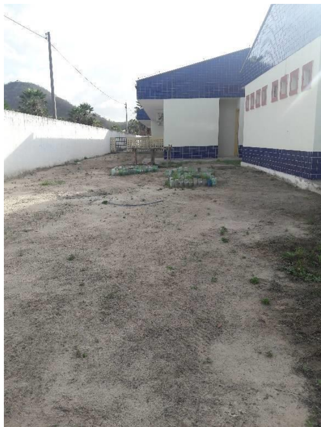
Foto 10 – Espaço Externo do CEI antes das intervenções
