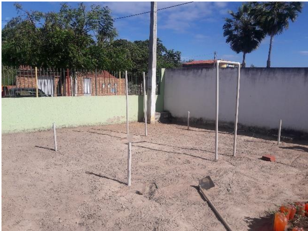
Foto 14 – Primeiras ações para a construção da estufa
