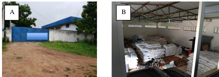
Figura 15 – Empresa E.A: A) Frente do escritório. B) Galpão.
