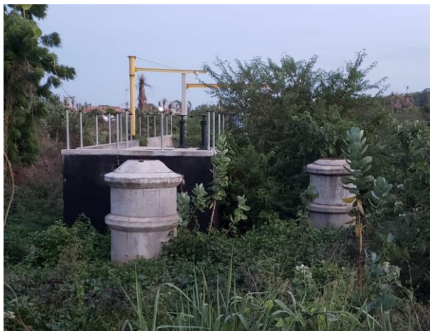
Figura 32 – Estação de Tratamento Elevatória localizada às margens da CE 060 no sentido sul da cidade de Aracoiaba
