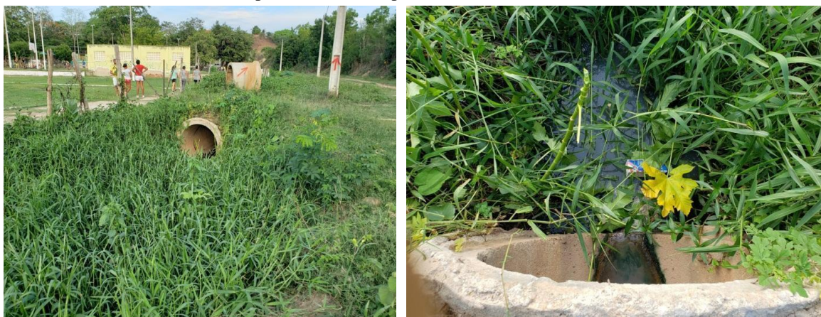
Figura 30 – Esgoto saindo de uma manilha como ponto final de saneamento básico, localizado na lateral da parte de baixo do polo de Lazer de Aracoiaba.
