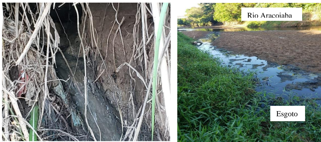
Figura 31 – Esgoto saindo da manilha localizada logo abaixo do calçadão no polo de Lazer de Aracoiaba indo em direção ao Rio Aracoiaba.
