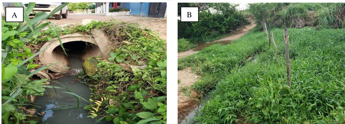
Figura 29 – Localização de esgotos a céu aberto seguindo percurso em direção ao Rio Aracoiaba: A) final da Rua Santos Dumont no sentido Rio Aracoiaba no centro da cidade e B) manilha de concreto existente no final da Rua Santos Dumont.
