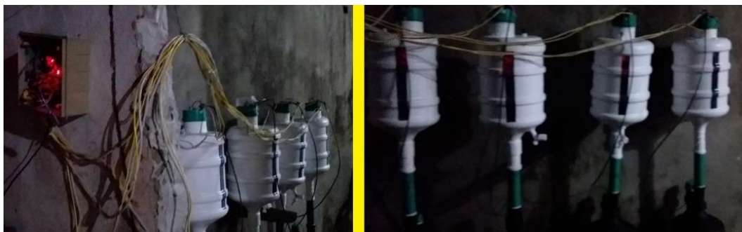
Figura 54 – Fotografia dos Biodigestores em Operação
