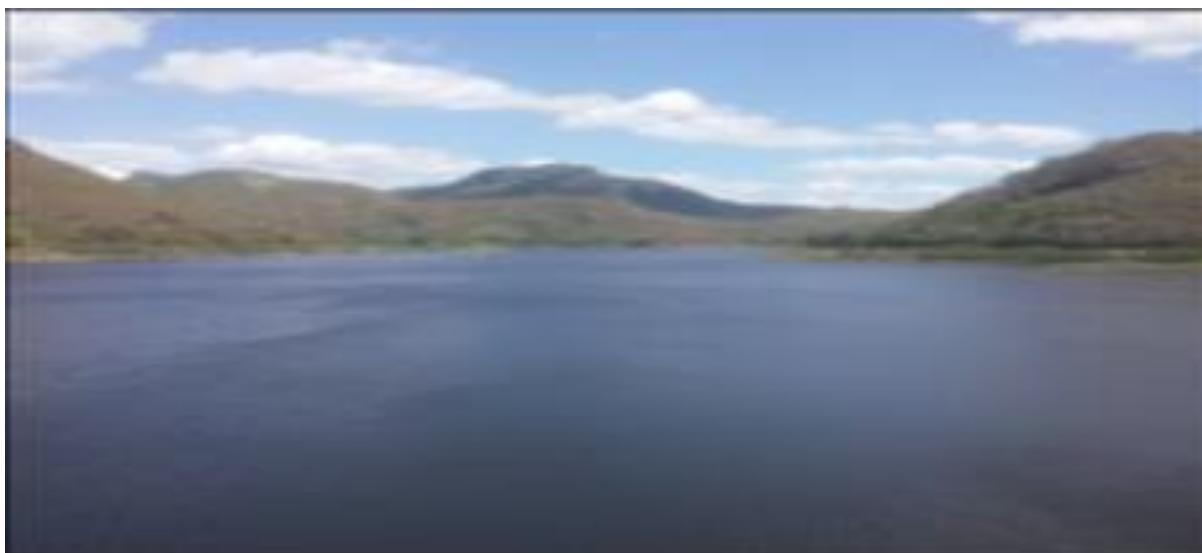
Figura 6- Açude Acarape do Meio (julho 2016)
