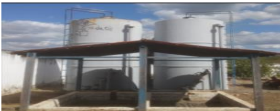
Figura 10- Estação de tratamento de esgoto no bairro Boa Fé Redenção- CE
