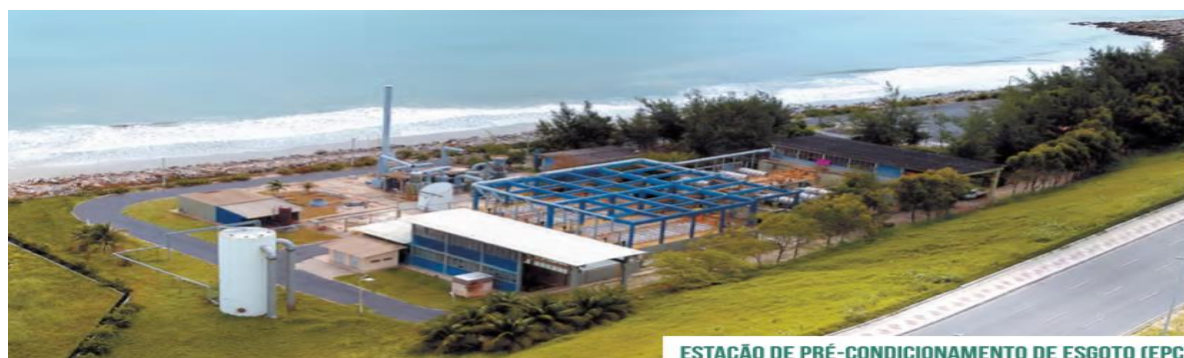
Figura 11- Estação de Pré- Condicionamento de esgoto.
