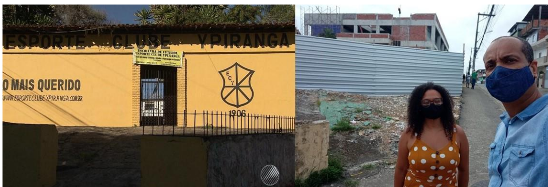
Figura 3 - Entrada antiga e a futura entrada em construção
