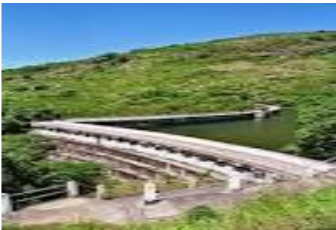
AÇUDE ACARAPE DO MEIO ( LOCALIZADO ENTRE AS SERRAS DE BARRA NOVA E BRENHA)
