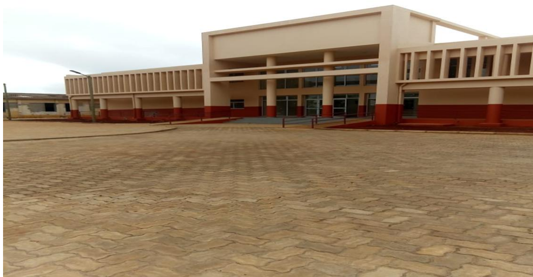
Imagem 3: Novo Edifício do Hospital Provincial de Lichinga
