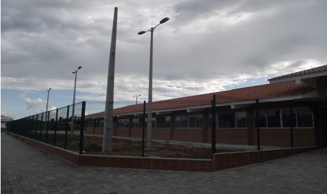
Foto 01. Fachada da Escola
