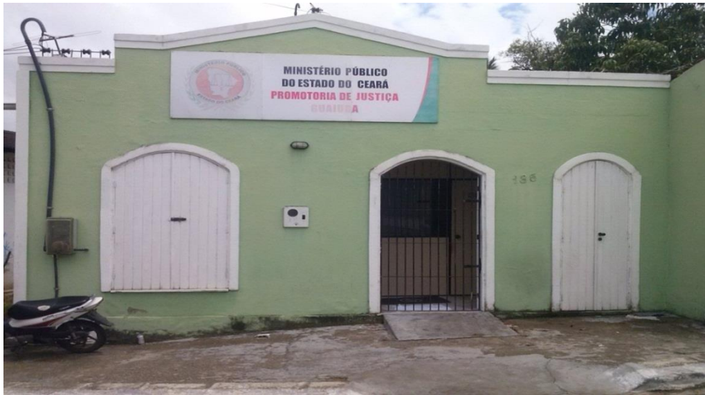
Figura 04: Fachada do prédio do Ministério Público de Guaiuba- CE
