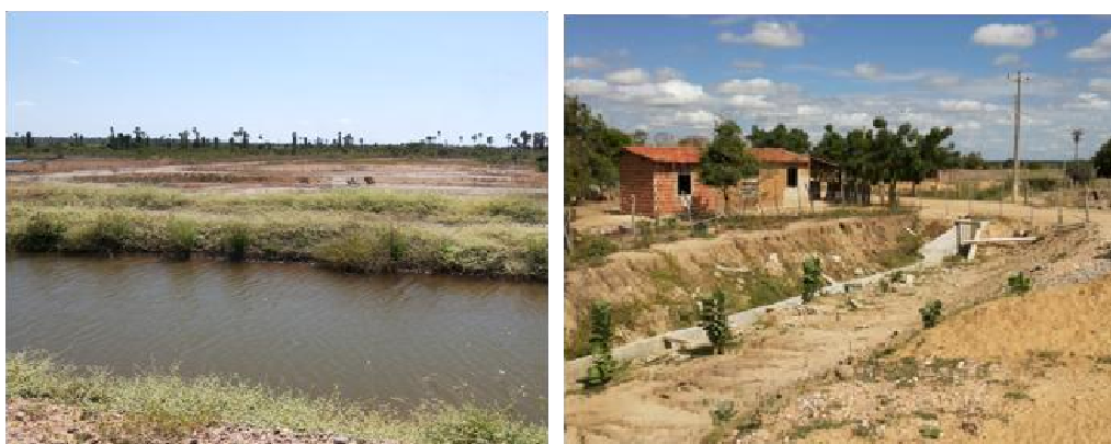
Figura 3: Lançamento de efluentes e canal de reabastecimento da fazenda estudada.
