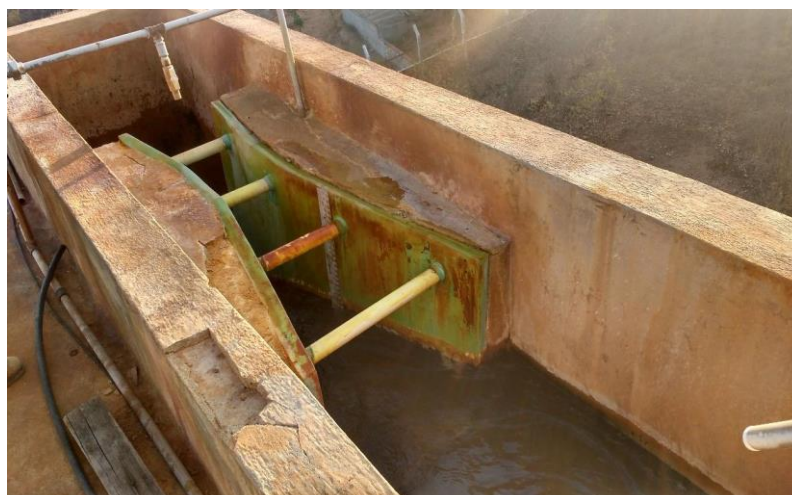
Figura 4 – Calha Parshall
