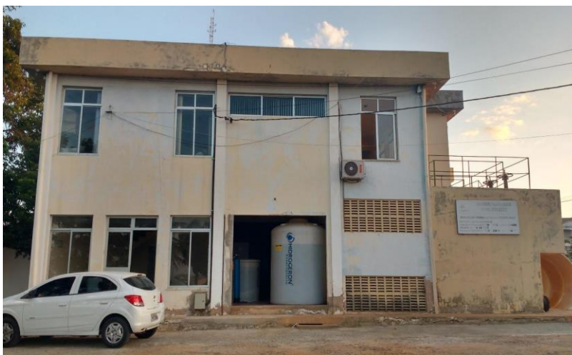
Figura 3 – Estação de Tratamento de Água do SAAE Jaguaribe
