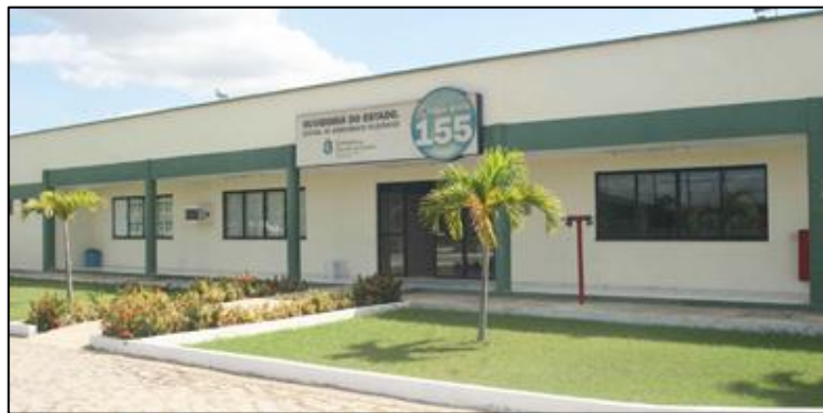
Figura 5 - Prédio da Central de Atendimento Telefônico 155 - Canindé/Ceará
