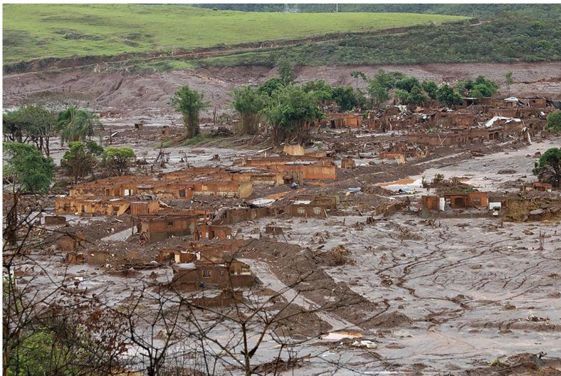
Figura 5 – Distrito de Bento Rodrigues após o rompimento da barragem de Fundão.
