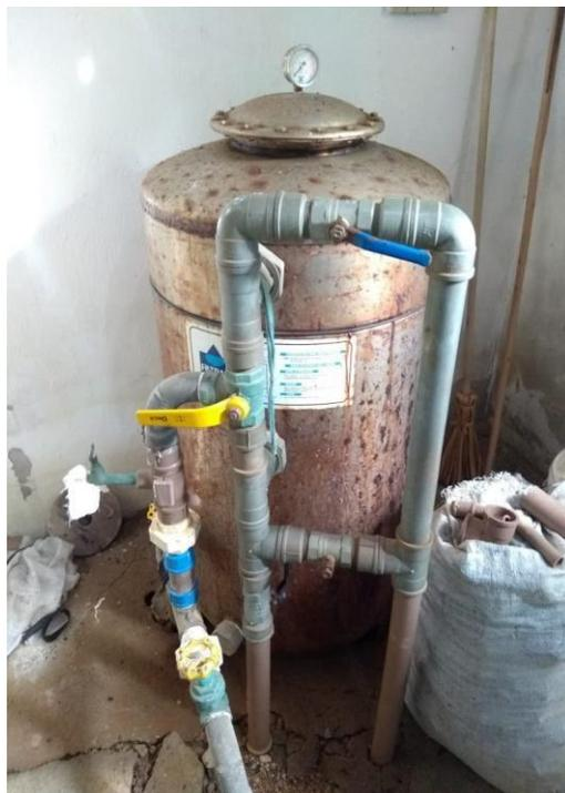
**FIGURA 10:** Filtro utilizado na estação de tratamento
