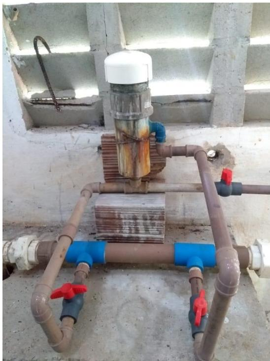
**FIGURA 11:** Reservatório para colocar o cloro localizado na estação de tratamento.
