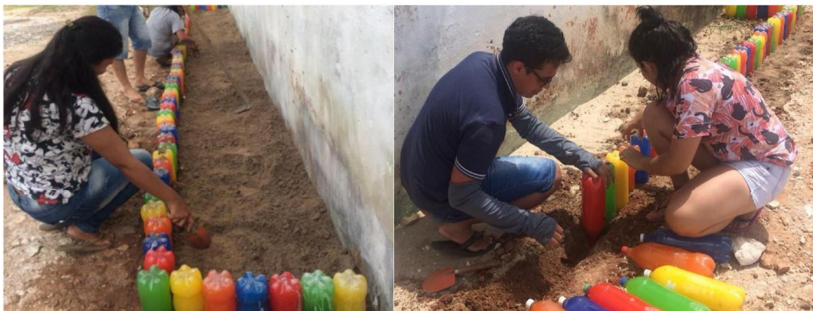
Figura 17 Construção dos canteiros com garrafas PET.
