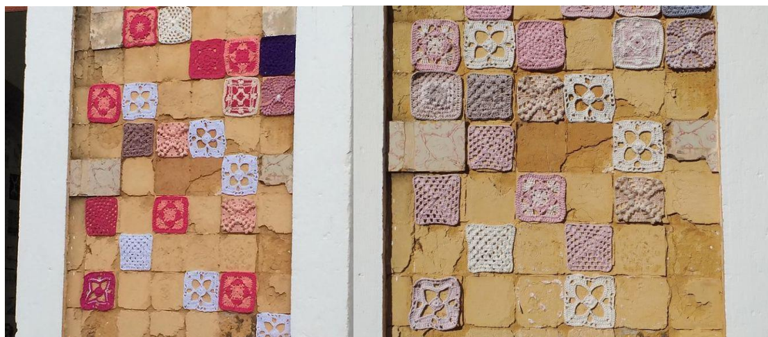
Figura 34 e 35 - Intervenção Azulejos na fachada da Galeria Chão, anos 2017 e 2020
