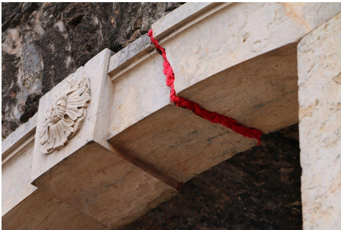
Figura 59 - Intervenção Fissuras. Local: Alcântara. Ano: 2017
