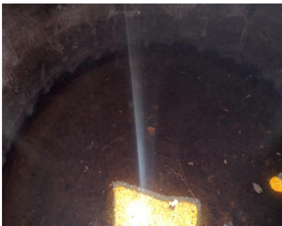
Figura 12 – Tanque do Sistema Bioágua Familiar (SBF) (2020)
