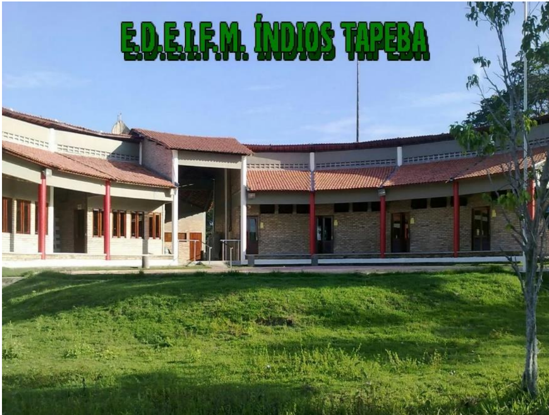
Figura 3: Escola Índio Tapeba (Caucaia)
