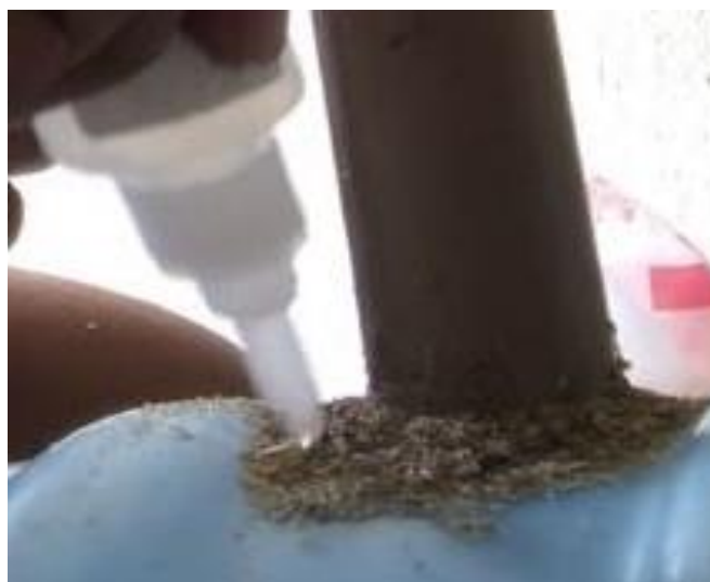
Figura 10. Fechar os tubos e evitar a entrada de ar no biodigestor Fonte: Autor (2018)
