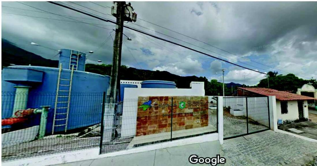
A ETA foi construída em meados do ano de 1975, ampliada no ano de 1999. O volume de água armazenada nos seis tanques existentes é de aproximadamente  $24 \text{ m}^3$ . A Figura 2 mostra um mapa com a localização do açude Gavião e do município de Maranguape - CE. A água bruta é proveniente do manancial Gavião que fica a 50 km de distancia da ETA. A água bruta do manancial é transportada através de tubos.
