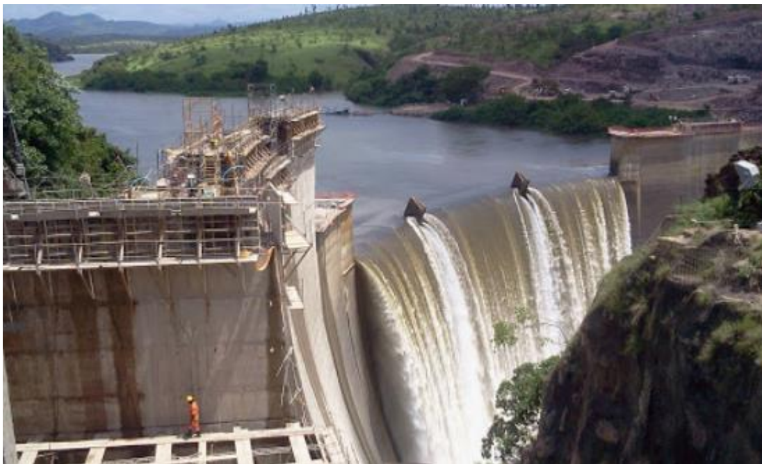
Figura 16 - Construção da barragem de Caculo Cabaça
