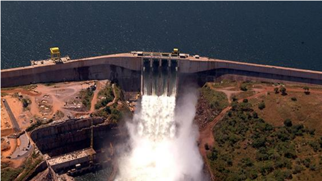
Figura 15 - Barragem de Capanda
