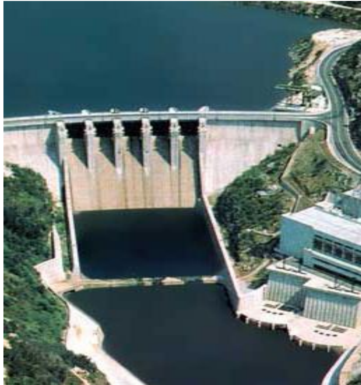
Figura 13 - Barragem de Laúca
