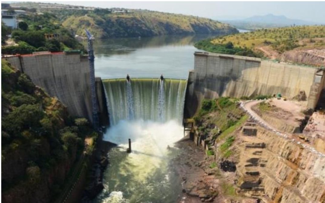
Figura 14 - Barragem de Cambambe
