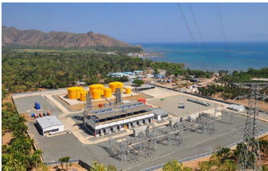
Figura 11. Central Elétrica de Hera
