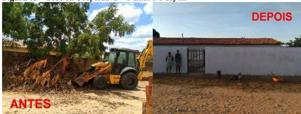
Figura 03 – Sede da Cooperativa – o antes e o depois
