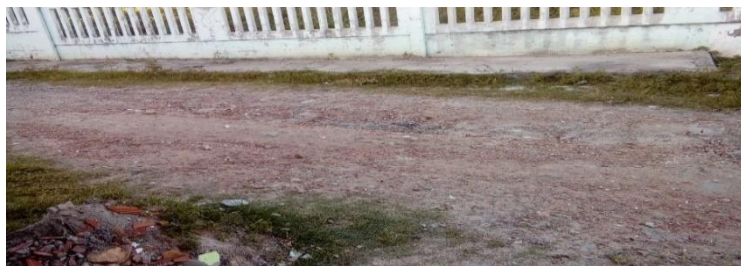
Imagem 05 – Rua do Trilho do Lado do Alto da Mangueira
