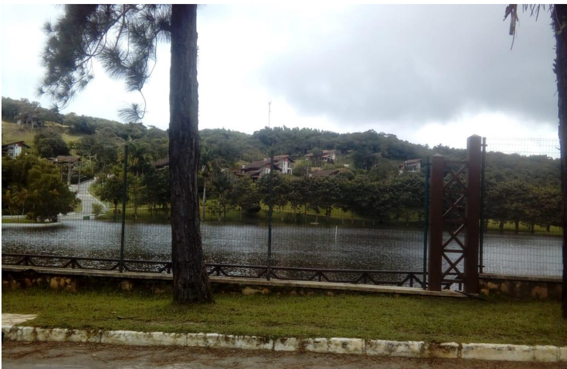
Figura 10. Vista do Condomínio Monteflor.
