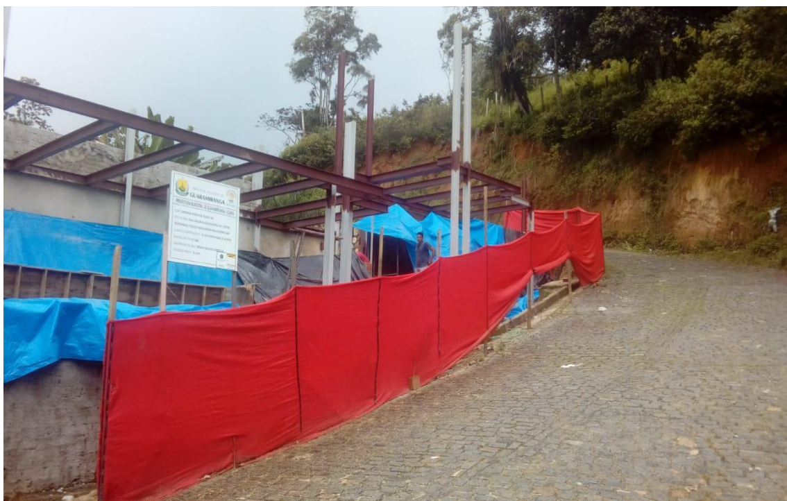
Figura 5. Vista de uma das várias obras em andamento no território do município no ano.
