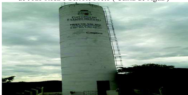
Figura 25 Sistema de Abastecimento de Água das comunidades de João Rosa e Serrote Preto ( Caixa de Água )
