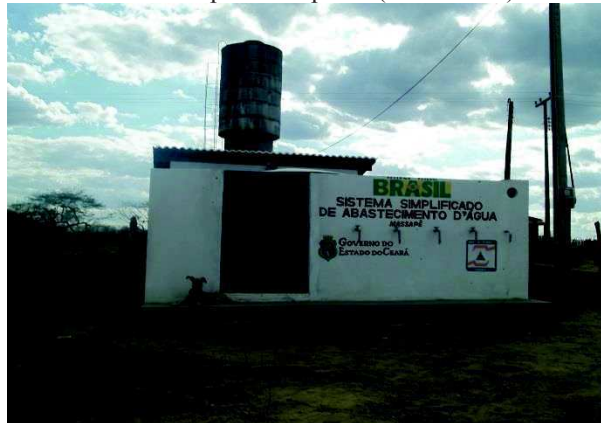
Figura 20 Poço profundo da comunidade Massapé, a 10km da sede do município de Itapiúna ( zona rural ).
