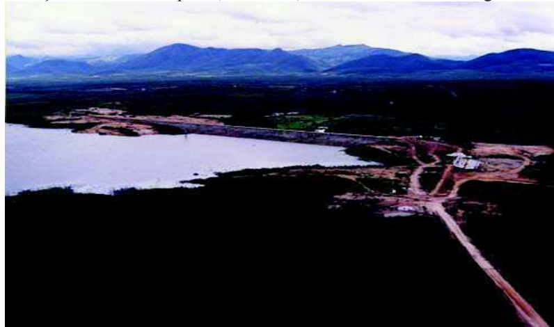
Figura 12 Açude Castro de Itapiúna, ano 2007, recém construído e inaugurado
