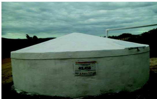
Figura 23 Cisterna de placa da Comunidade de Carnaubinha dos Bezerras, a 1,6 km da sede de Itapiúna, referente ao Projeto Brasil Sem Miséria sob Convênio nº. 239/2009.
