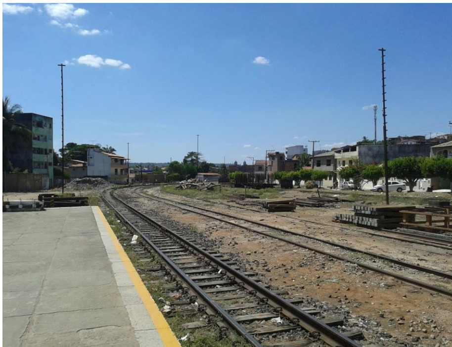
Figura 36: Pátio da Estação Ferroviária de Santo Amaro (2015). Fonte: Acervo digital de Marcus Vinícius Dias.
