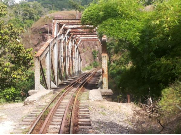
Figura 20: Pontilhão no percurso da Estrada de Ferro Santo Amaro (2014). Fonte: Acervo digital do autor.
