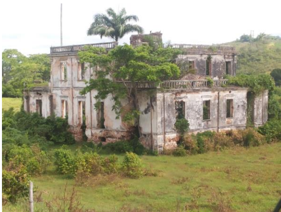
Figura 24: Ruínas da Casa-grande do Engenho Subaé no percurso da Estrada de Ferro Santo Amaro (2014). Fonte: Acervo digital do autor.
