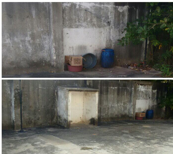
Figura 20 - Local de armazenagem do resíduo orgânico e abrigo não utilizado
