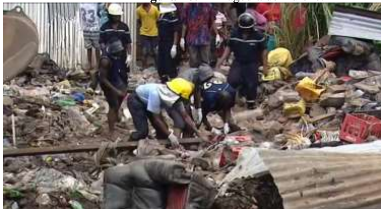
Figura 16: Tragédia de Hulene.
