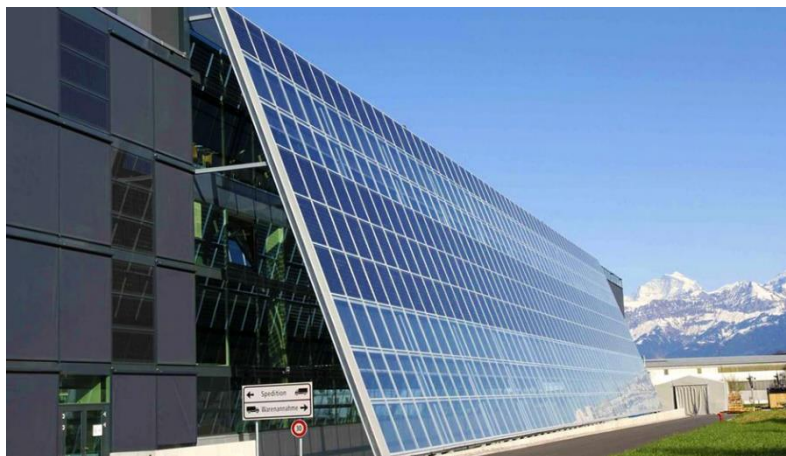
Figura 2.2 - Sistemas Fotovoltaicos Integrados
