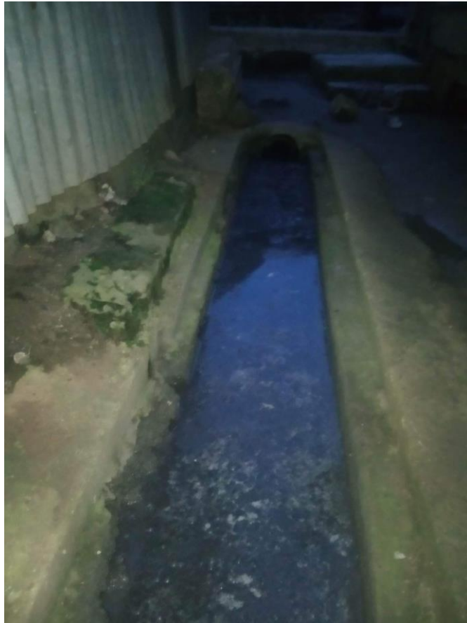
Figura 13- Esgoto a céu aberto sem Tratamento em Santo António
