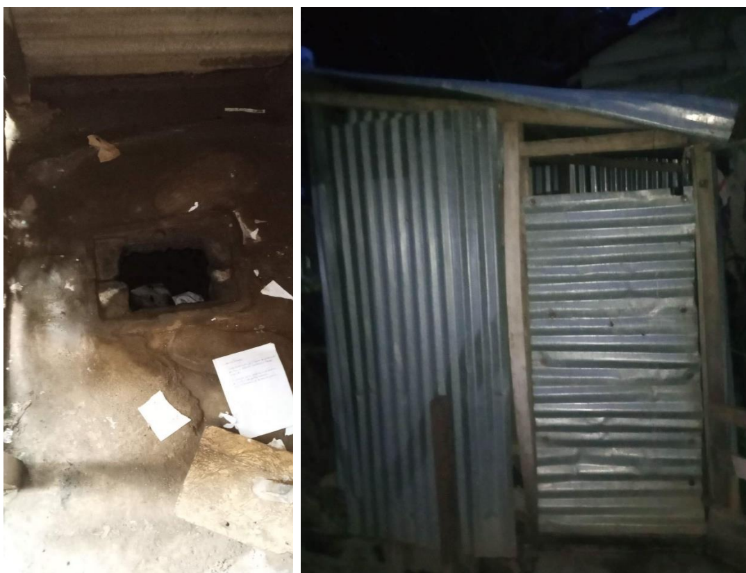
Figura 14 - Área interna e externa de uma latrina em Santo António
