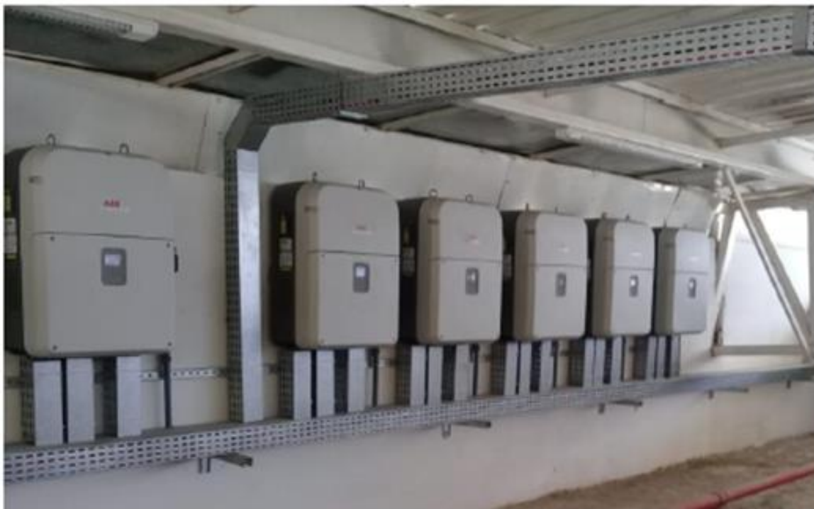
Figura 13 - Inversor da usina de minigeração do Campus das Auras
