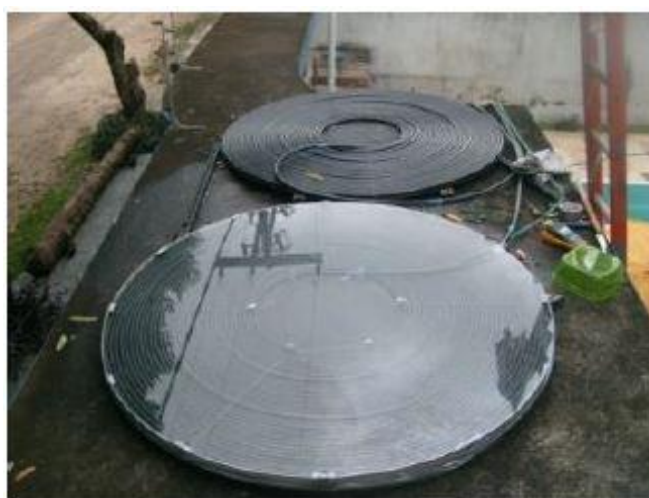
Figura 4 - Instalação dos equipamentos em local definitivo
