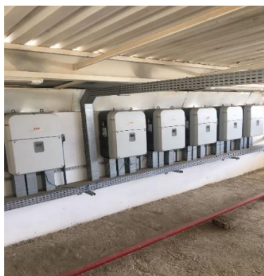
Figura 5- Inversores solares
