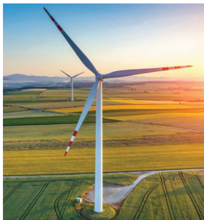
Figura 10 - Turbina eólica de eixo horizontal
