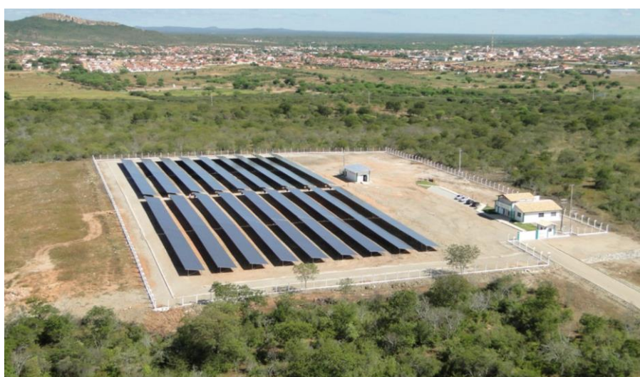
Figura 7 - Usina solar de Tauá.
