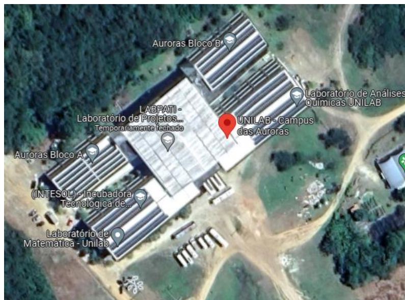
Figura 11 – Mapa de localização da usina fotovoltaica via Google Maps
